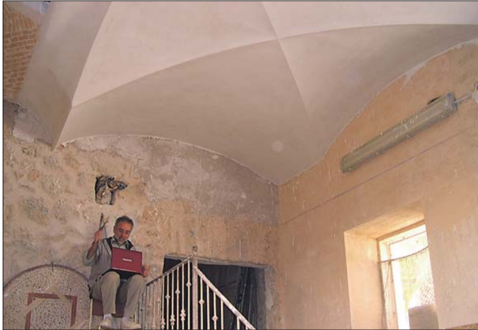
Miquel Ramis, junto a un techo de bóveda creado al estilo tradicional. FOTO: J. FRAU.
